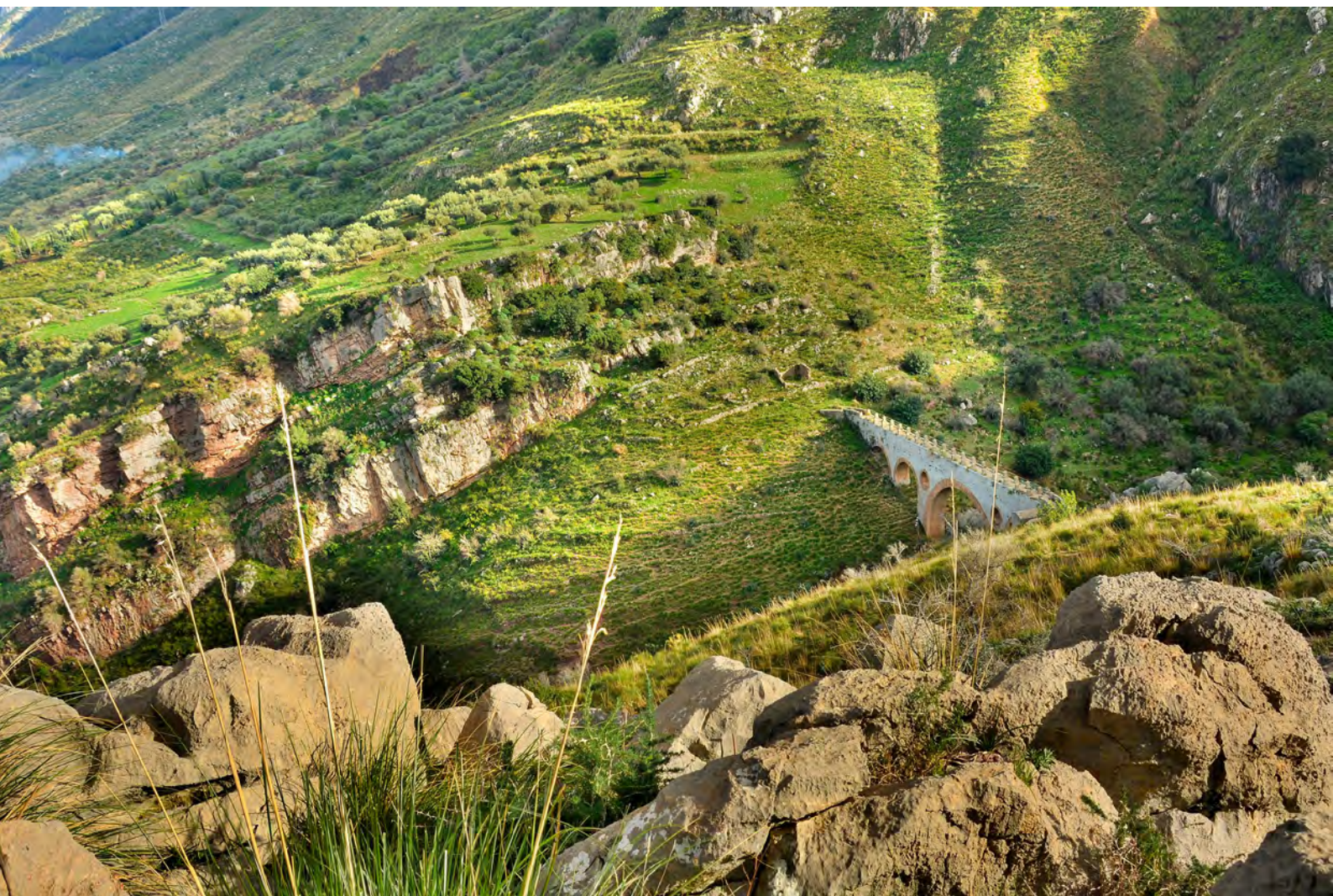
Fig. 14, Poggio Balate. Il ponte dell'acquedotto di Scillato sul Vallone Tre Pietre. In primo piano tra le rocce calcaree sede delle mineralizzazioni spunta "a disa", l' Ampelodesmo .
